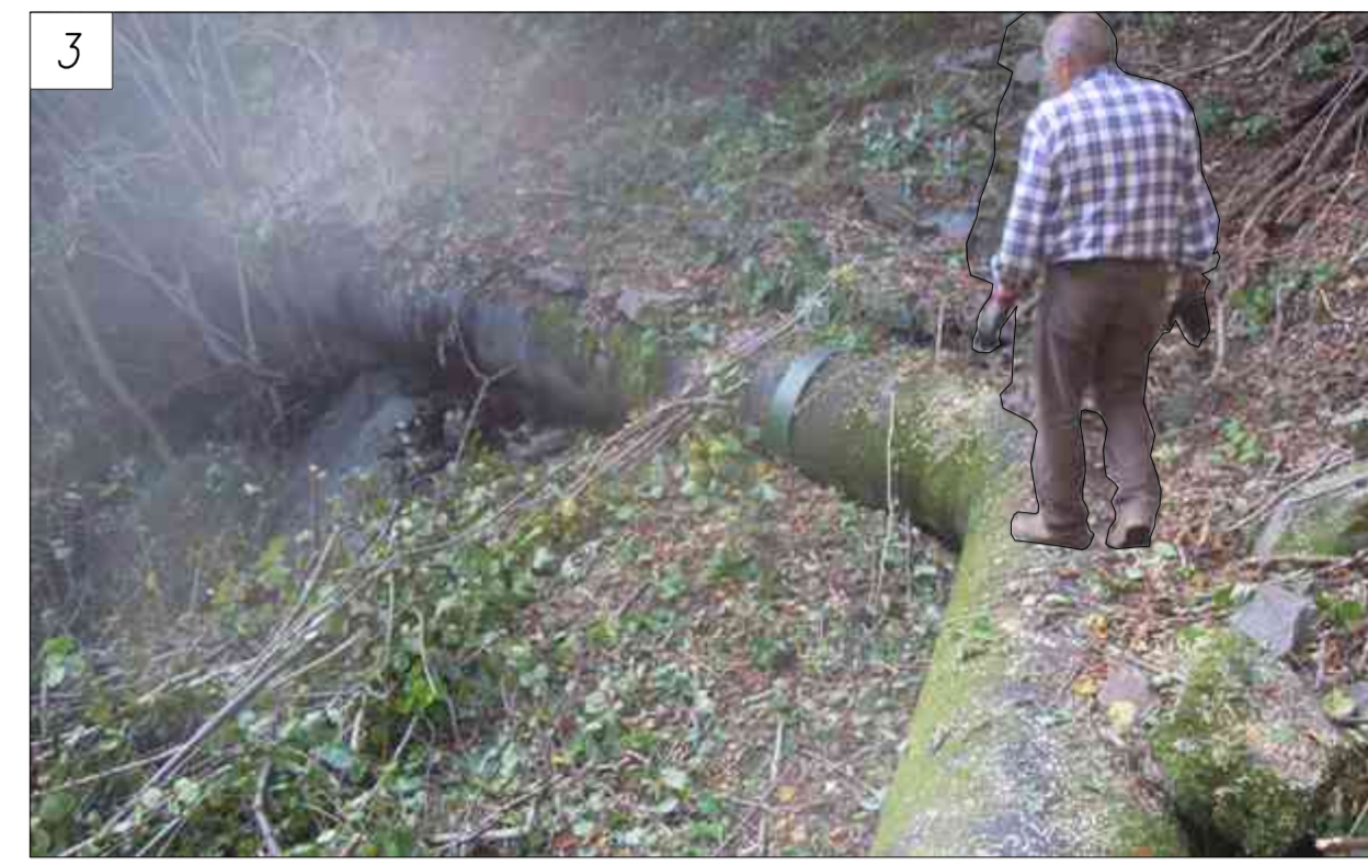
3 e 4: ATTRAVERSAMENTO DI PICCOLI COMPLUVI MEDIANTE LA REALIZZAZIONE DI SEMI BRIGLIA AVENTE COME CORPO LA CONDOTTA
