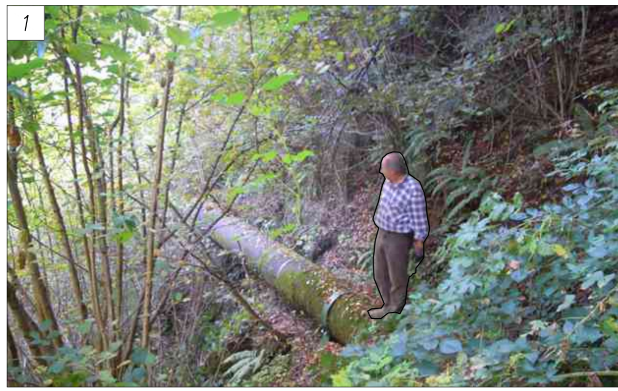
1 e 2: TRATTO DI VERSANTE DI NOTEVOLE PENDENZA CON CENGLIA RICAVATA MEDIANTE SCAVO E POSA CONDOTTA SU SELLE
